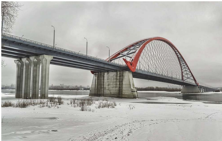
Рис. 17. Фотография Бугринского моста, г. Новосибирск
