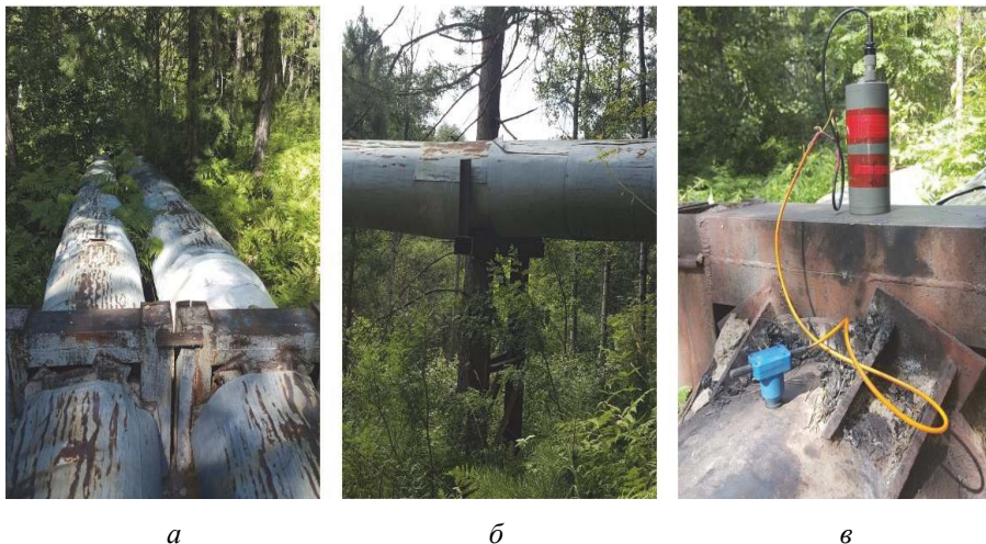
Рис. 10. Участок трубопровода с жестким креплением труб к опоре ( а ); трубы, уложенные на стойку без жесткого крепления ( б ); регистратор установленный на трубе, геофон ( в )
